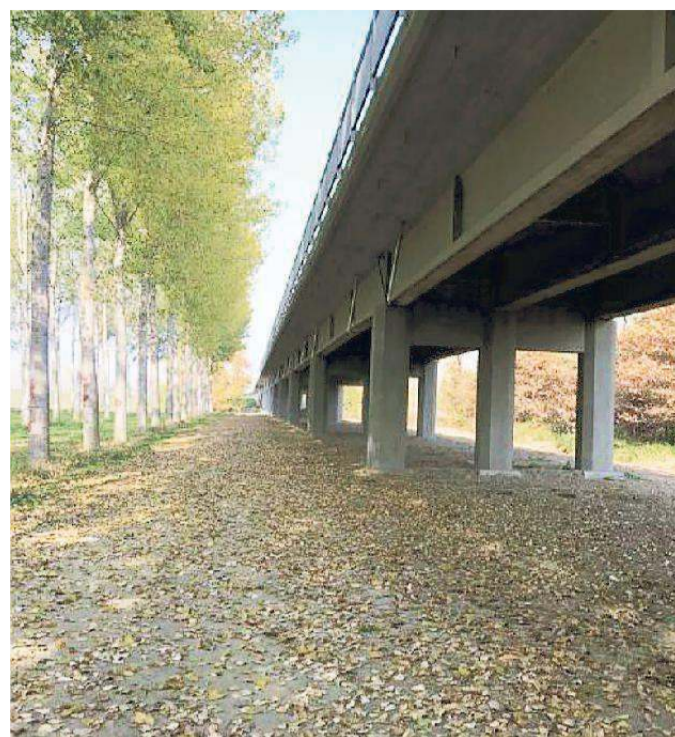
Il ponte di Viadana dopo i lavori di risanamento
